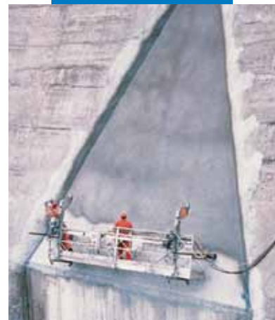
Ukázka Mapelasticu aplikovaného nástřikem na přehradní hráz
