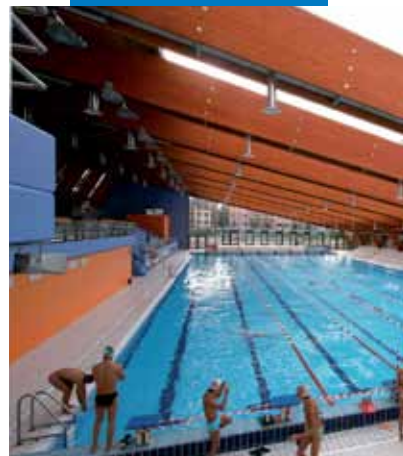
Bazén opatřený hydroizolací Mapelastic: Scarioni - Centrum volného času - Miláno - Itálie
