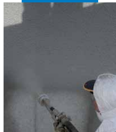
Ukázka Mapelasticu aplikovaného nástřikem na viadukt
