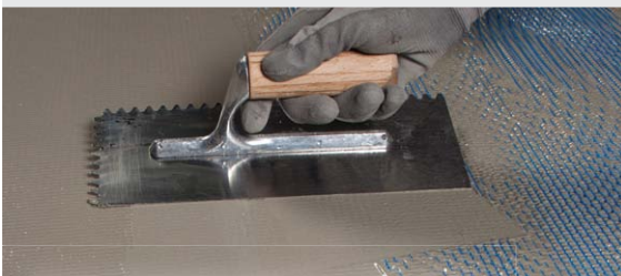
Aplikace první vrstvy Mapelastik Turbo s vložením síťoviny Mapenet 150
