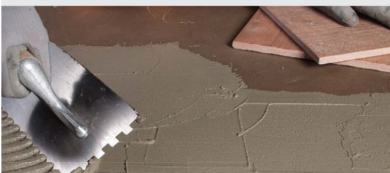
Lepení dlažby s použitím lepidla Granirapid
