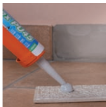
4/5. Vytlačte tmel ve tvaru profilu nebo bodově ve vzdálenosti 15 cm od sebe
