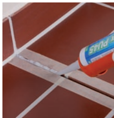
Dilatační spáry v podlahách
