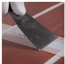
7. Vyhlaďte povrch tmelu ve spáře
