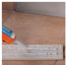
4/5. Vytlačte tmel ve tvaru profilu nebo bodově ve vzdálenosti 15 cm od sebe
