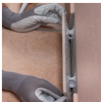
6. Dostatečně přitlačte k podkladu (tloušťka tmelu 3mm)
